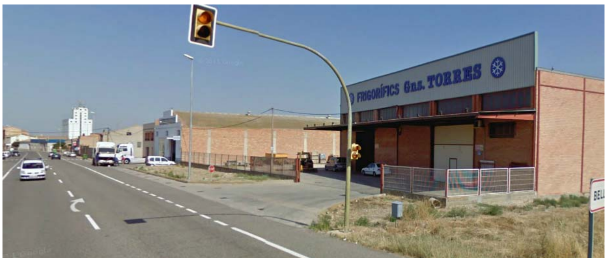
Av. Lleida núm. 28 - 32 (edificacions industrials existents)
