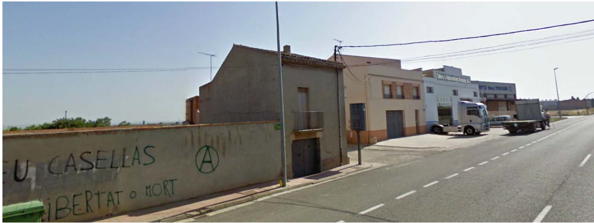
Av. Lleida núm. 2 (edificació residencial existent)
