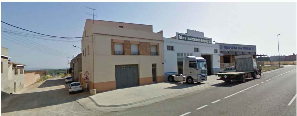
Av. Lleida núm. 26 (edificació residencial existent) i núm. 28 - 32 (edificacions industrials existents)
